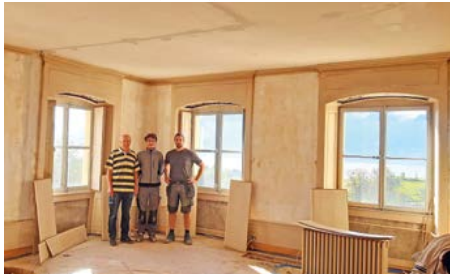
↓ Philippe Ducaux entouré de ses collaborateurs durant les travaux de réparation de boiserie (Dominique Muerset au milieu et Bastien Gentizon à droite) Photo : Philippe Ducaux
