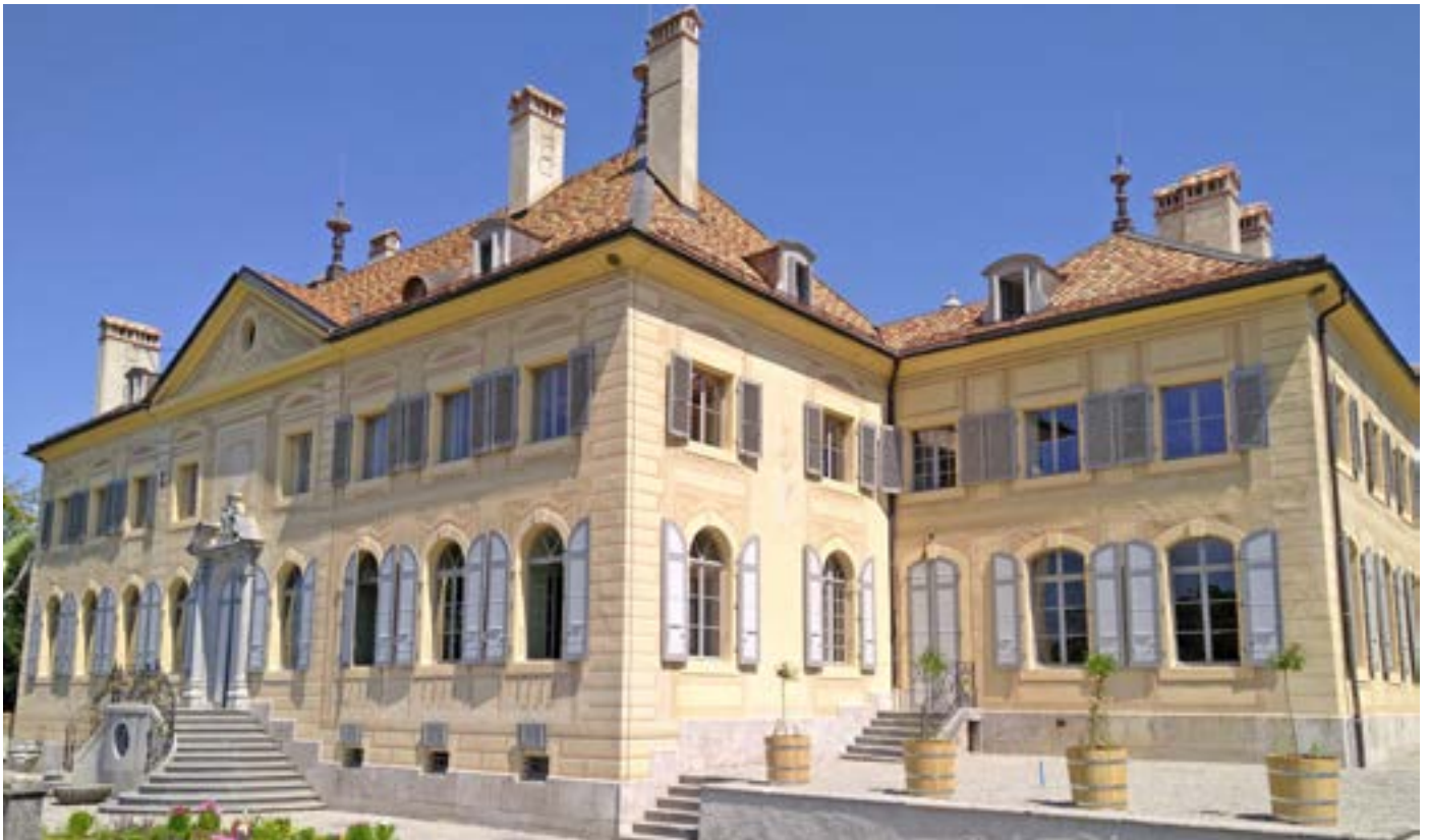
↑ Vue extérieure du château à la fin des premiers travaux en juillet. Photo : Philippe Ducraux
