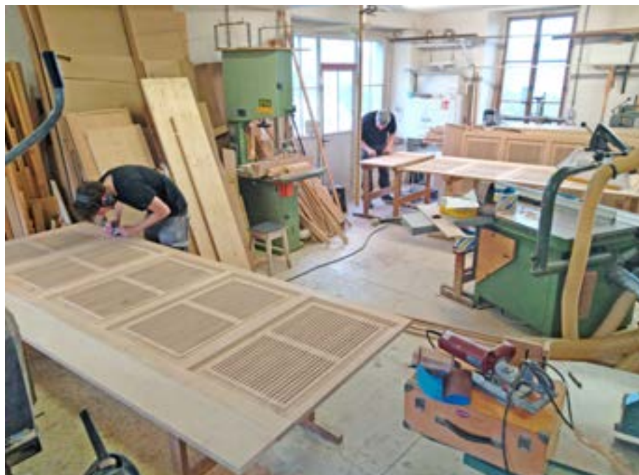
↑ Façonnage des éléments pour le réfectoire. Photo : Philippe Ducraux
