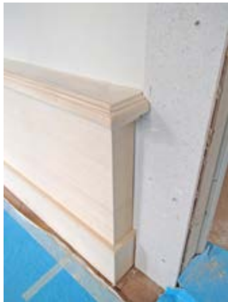
↑ Exemple de boiserie refaite à l'identique dans le château. Photo : Philippe Ducraux
