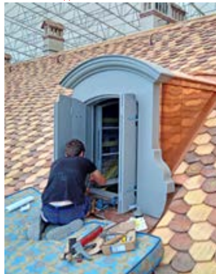
↓ Pose des volets pliables sur les lucarnes. Photo : Philippe Ducaux
