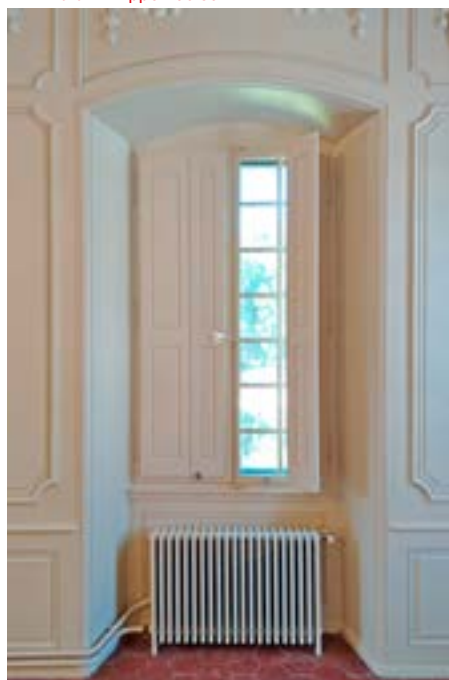
↓ Volets intérieurs une fois posés. Photo : Philippe Ducraux
