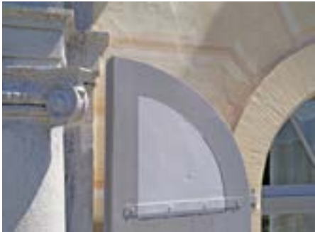
↑ Rénovation des volets extérieurs. Photos : Philippe Ducaux
