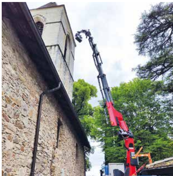
Le moteur et le treuil du mât porte-drapeau ont été extraits par la toiture de l'église en juin dernier.
